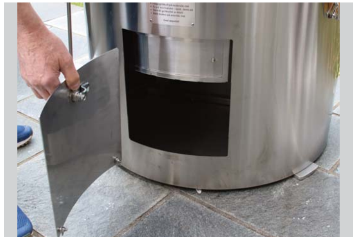
Inspeksjonsdør for asketømming.
